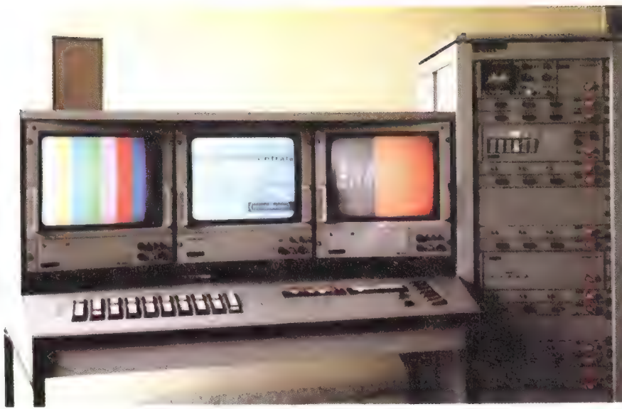
Die Steuerzentrale des schulinternen Fernsehsystems
